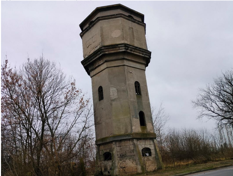
Zdjęcie 6 Pozostałości kolejowej wieży ciśnień
