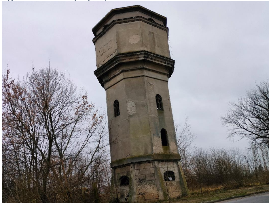
Zdjęcie 6 Pozostałości kolejowej wieży ciśnień
