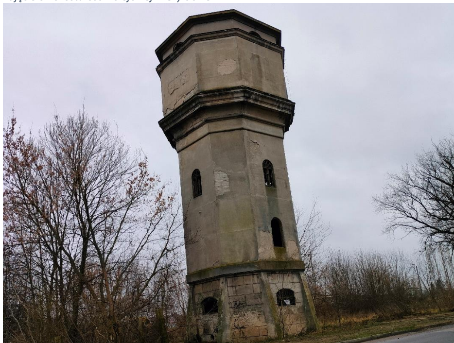
Zdjęcie 6 Pozostałości kolejowej wieży ciśnień
